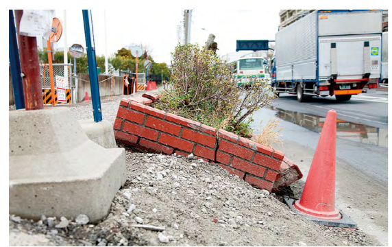
液状化による道路の被害例
