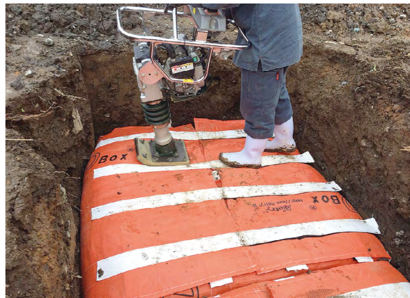
D・BOX-LS（形状保持型吊上げ直方体バッグ）。内部に拘束バンドを備えた袋に土を入れ、袋の上から圧力をかけることで固化させる。
