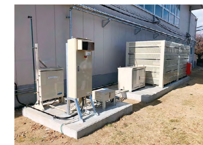
BOGETS構成装置。左から、パージユニット、New PA制御盤、ワンウェイロックバルブ、New PA本体、LPガス容器
